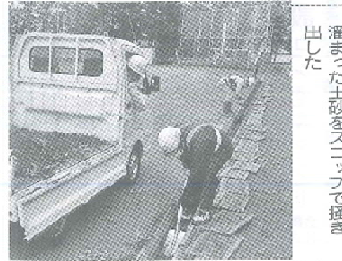
溜まった土砂をスコップで掻き出した
