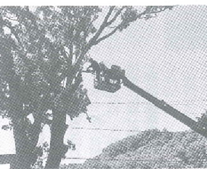
高所作業車も活用した
