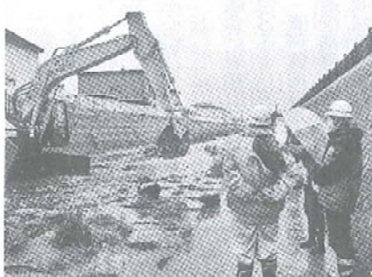
重機で川底を掘削した
