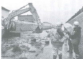
重機で川底を掘削した
