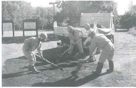
28年災901号美生川災復(同三田村拓海氏)を施工している。
